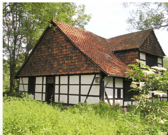
Haus Entenfang vor der Sanierung
